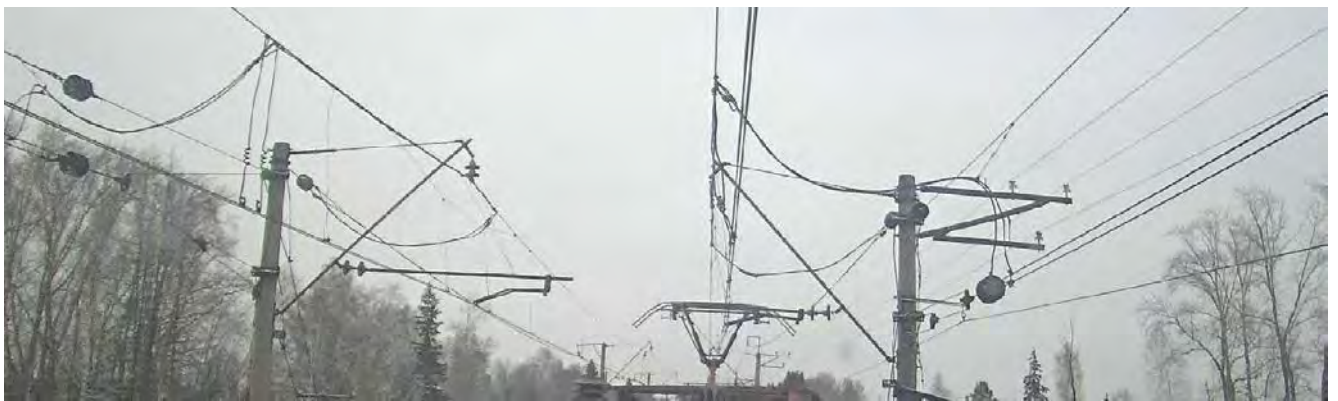
Рисунок 4.11 – Узел обвода усиливающего провода
